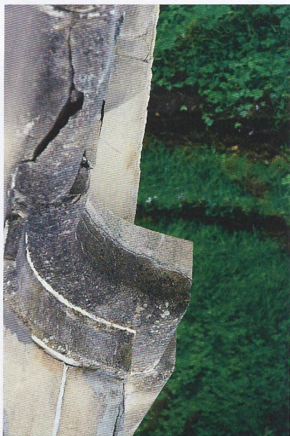
Fot.8 Silne spękania elementu mostu
