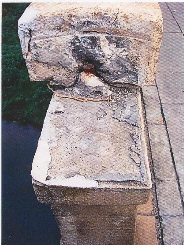
Fot.3 Zbrojenie balustrady – widoczny fragment płaskownika do zabezpieczenia
