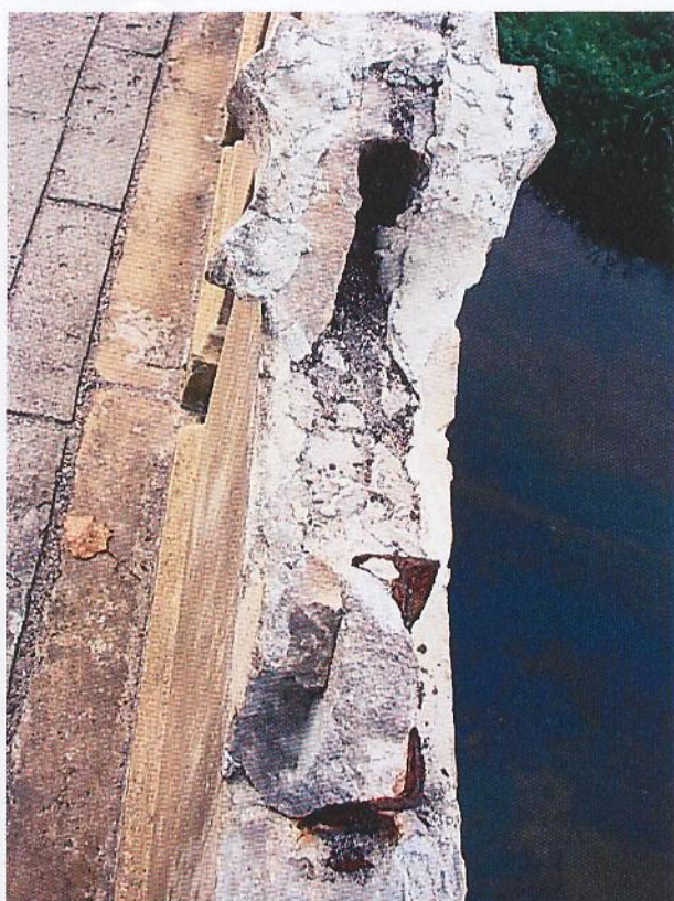
Fot.4 Zniszczenia górnego fragmentu balustrady
