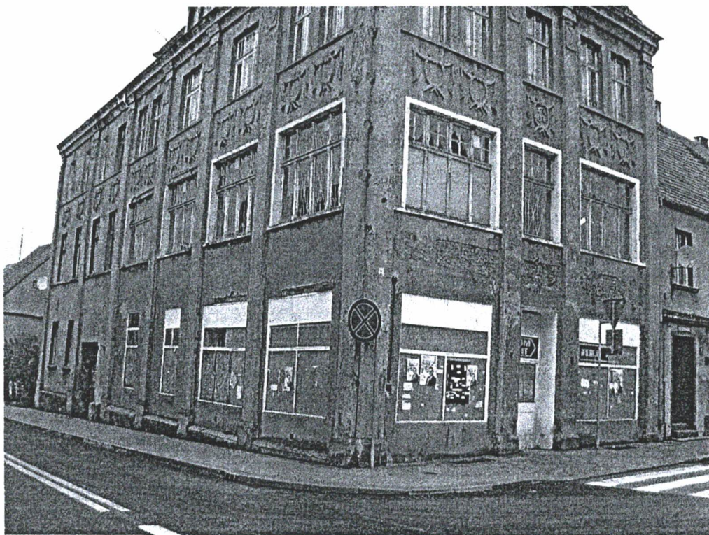
Fot. Nr 14 Zabezpieczone witryny okienne parteru na elewacji od strony ul. Kościuszki i ul. Witosa
