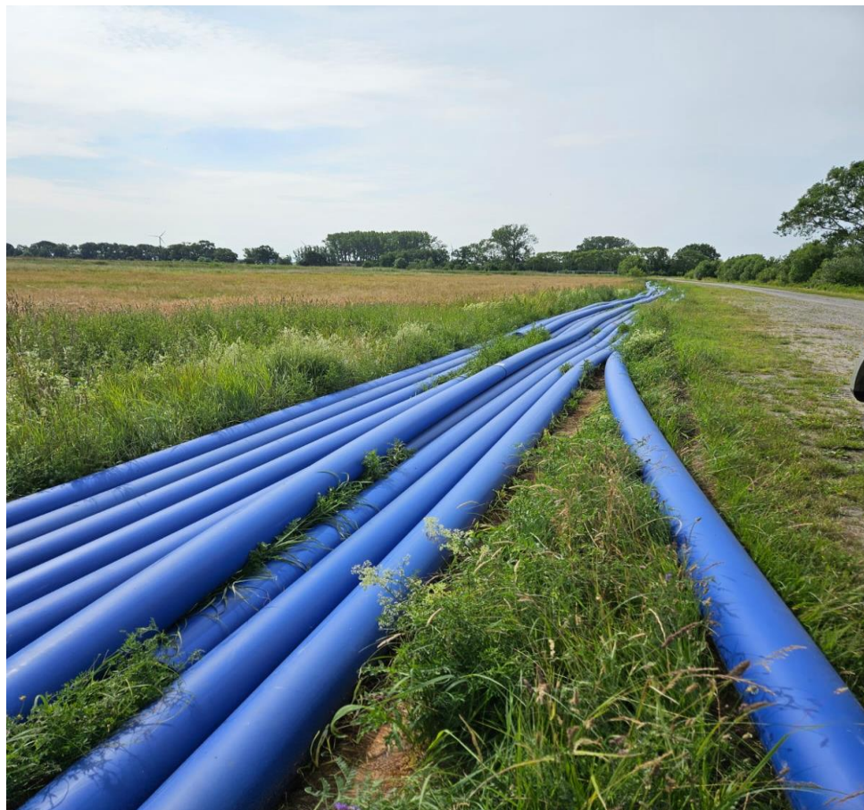
Zdj. 7.4 ZWIK - Budowa wodociągowej sieci rozdzielczej koło miejscowości Roby
