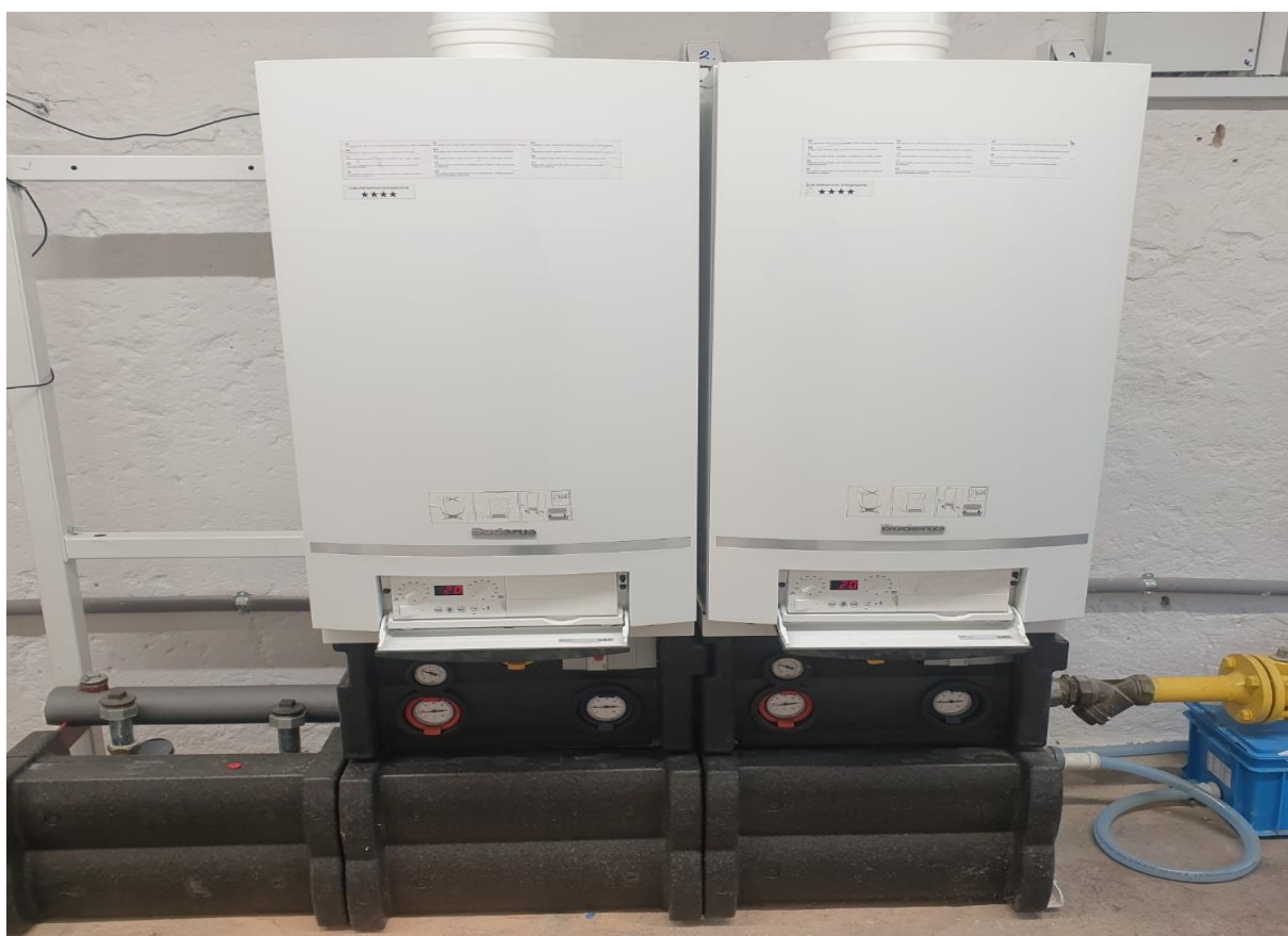
Zdj. 18.3 INWESTYCJE - Kaskada dwóch kotłów gazowych, Hala Sportowa, ul. Sportowa 19 w Trzebiatowie.
