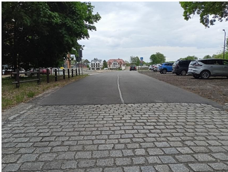
Zdj. 6.2 Wykonanie nowej nakładki bitumicznej przy moście w Mrzeżynie
