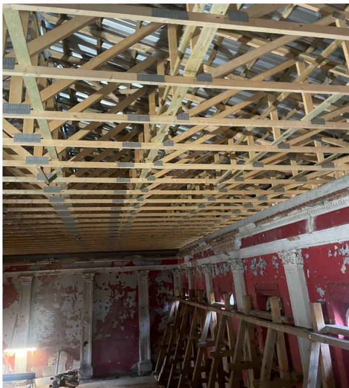
Zdj. 18.4 INWESTYCJE – Zabezpieczenie dachu Sali taneczno-koncertowej w wyłączonym z użytkowania Domu Kultury w Trzebiatowie
